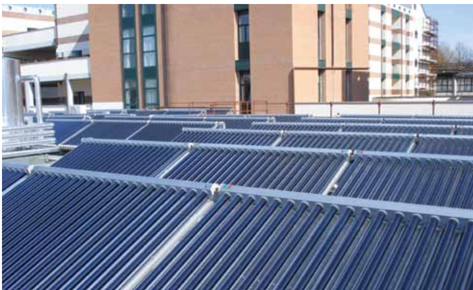
IMPIANTO REALIZZATO PRESSO LA CASA DI CURA SANTA MARGHERITA DI PAVIA, PREMIO "INNOVAZIONE AMICA DELL'AMBIENTE" 2009
