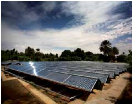
IMPIANTO COMBINATO DI SOLAR COOLING COMPOSTO DA 288 COLLETTORI SOLARI A TUBI SOTTOVUOTO KLOBEN, REALIZZATO PRESSO L'OSPEDALE DI CARDIOCHIRURGIA INFANTILE DI SOBA, IN SUDAN
