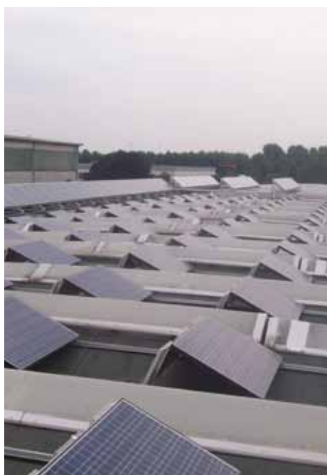
L'IMPIANTO FOTOVOLTAICO DA 45,15 KWP È STATO REALIZZATO NEL 2006 DA GIGAWATT DI PIZZIGHETTONE
