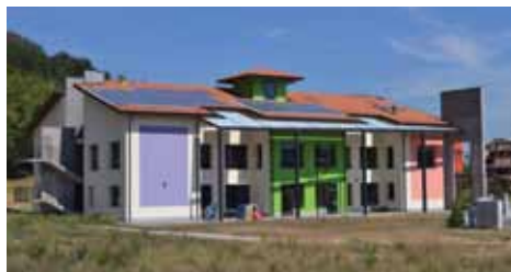
IL NUOVO POLO SCOLASTICO DI TRESSANO È DOTATO DI UN IMPIANTO FOTOVOLTAICO COSTITUITO DA 81 PANNELLI IBC SOLAR
