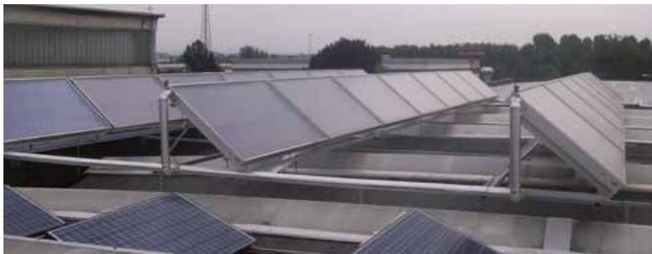
L'IMPIANTO SOLARE TERMICO NELL'ARCO DEI PRIMI SETTE MESI DEL 2011 HA PRODOTTO 12.430 KWH CON UN RISPARMIO DI 1.200 EURO SULLA BOLLETTA
