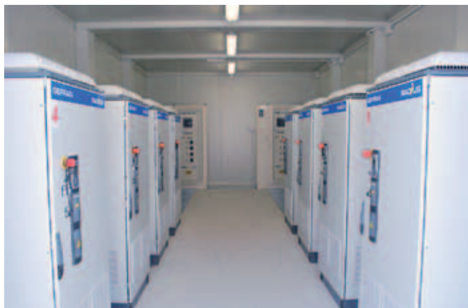
Figura 2 - Inverter per la conversione elettrica della tensione prodotta dai pannelli alla tensione di rete.
