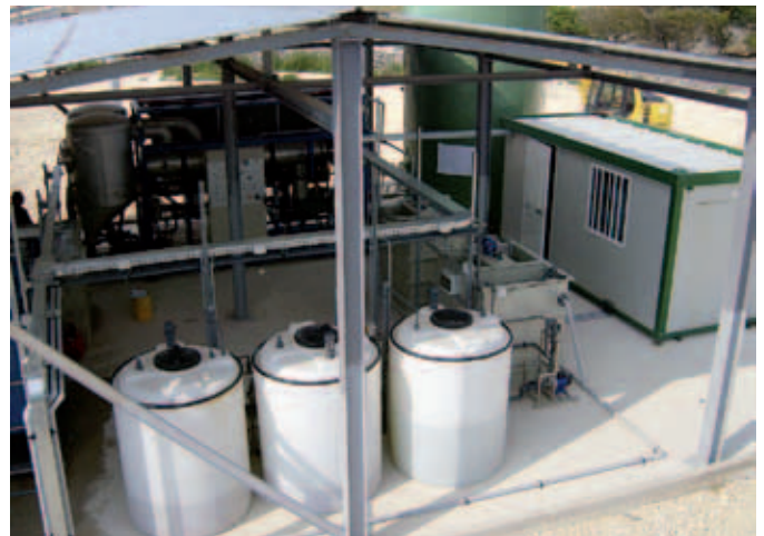
Impianto di trattamento del digestato.
